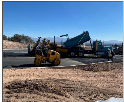
Paving - Mirador Subdivision
